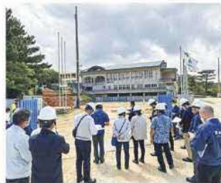
山田小学校プール整備工事
