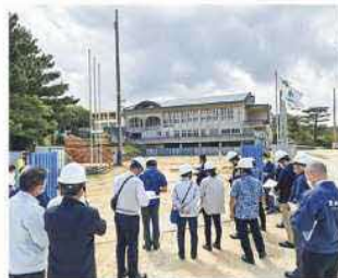
山田小学校プール整備工事
