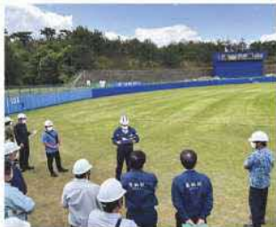
赤間野球場電光掲示板改修工事
