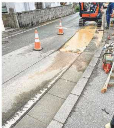
▲水道管の現状
