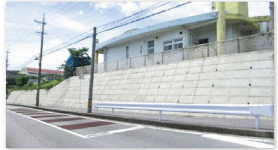
▲恩納村立山田小学校擁壁工事
