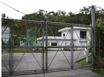
浸出液処理施設
