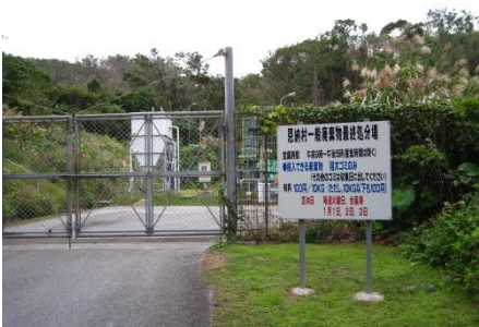
一般廃棄物最終処分場
