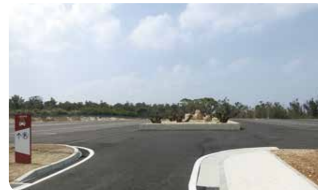
万座毛周辺活性化施設駐車場
