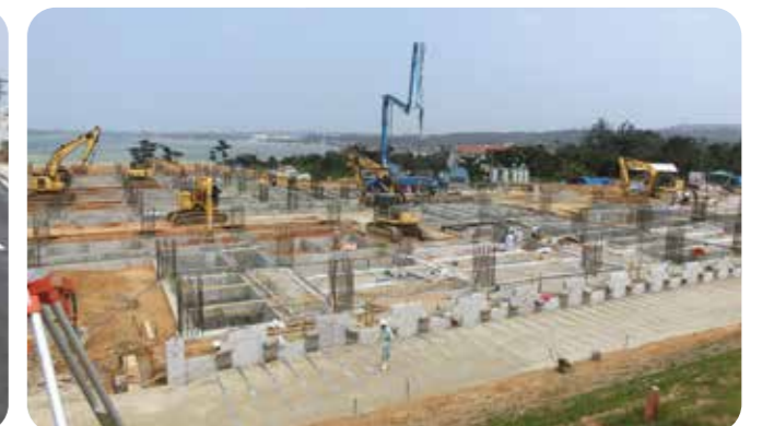
統合中学校整備工事(赤間)
