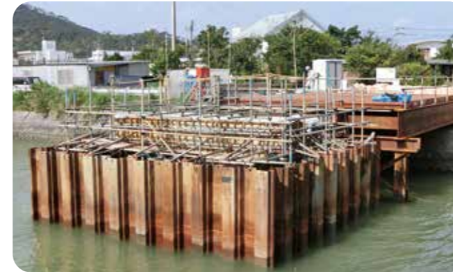
名嘉真川橋梁新設工事
