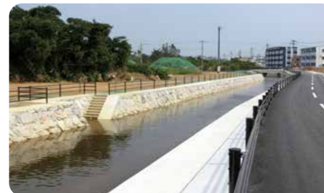
勢高排水路整備工事(南恩納)
