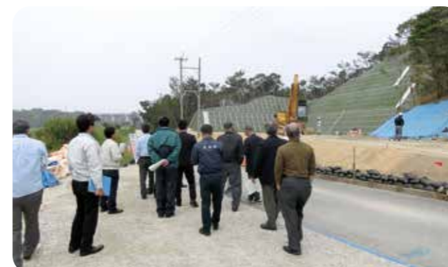
最終処分場浸出水処理施設工事(富着)
