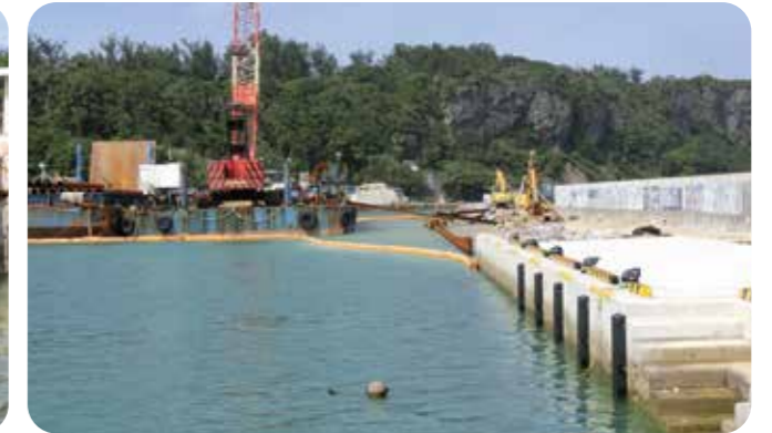
恩納漁港整備工事
