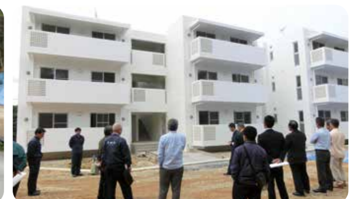
宇加地団地新築工事
