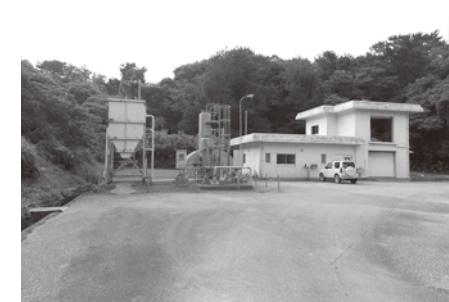
廃棄物最終処分場浸出水処理施設
