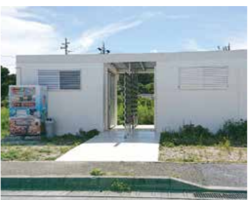
前兼久漁港仮設トイレ
