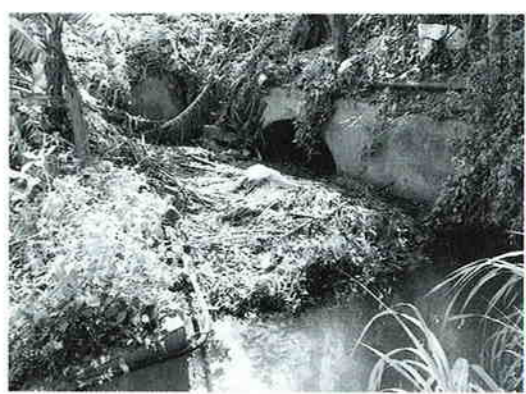
▲ワチ川排水溝の状況
