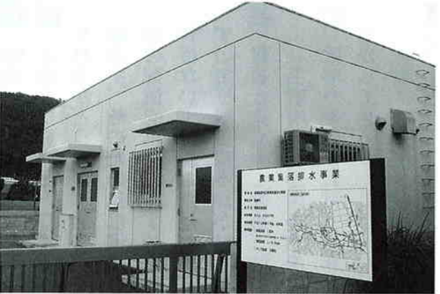
▲喜瀬武原下水処理施設
