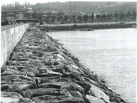
恩納漁港護岸
