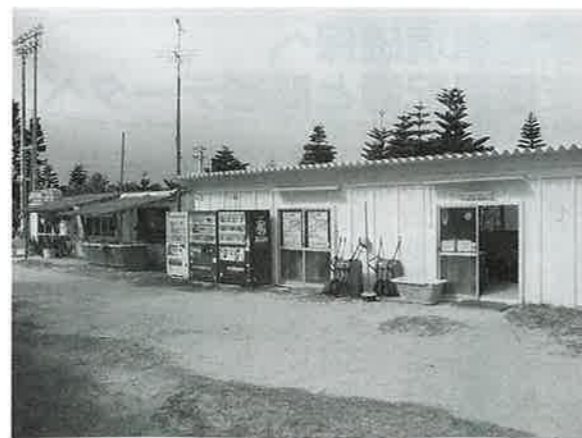
老朽化している現在の管理棟
