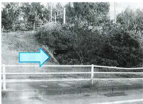
仲泊北交差点付近のトンネル入口
