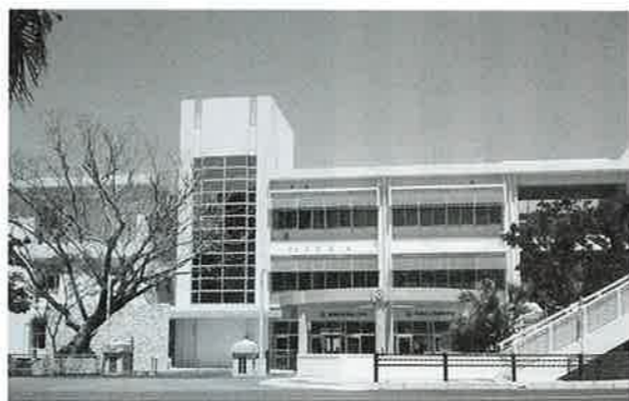
改築が完了した恩納小中学校校舎
