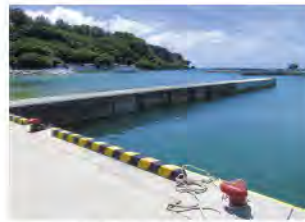
恩納漁港整備工事
