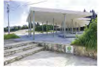
海浜公園休憩施設新築工事
