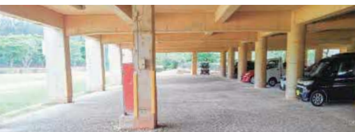
▲安富祖小学校体育館下駐車場の現状
