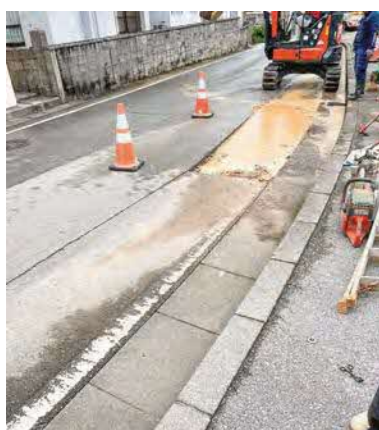
▲水道管の現状
