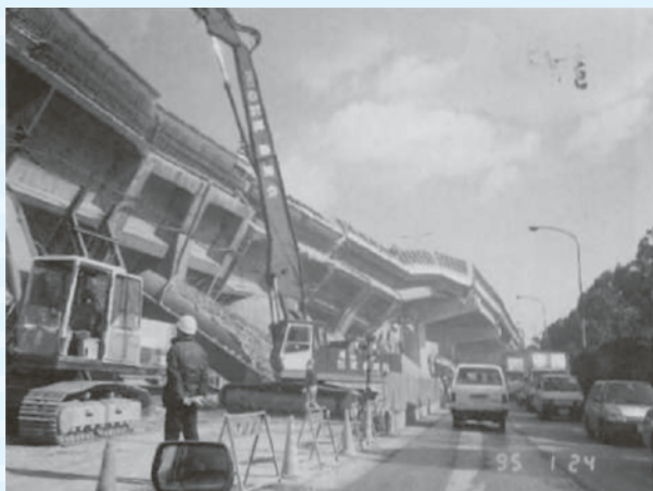
阪神高速道路の倒壊 「平成7年(1995年)兵庫県南部地震」(気象庁撮影)
