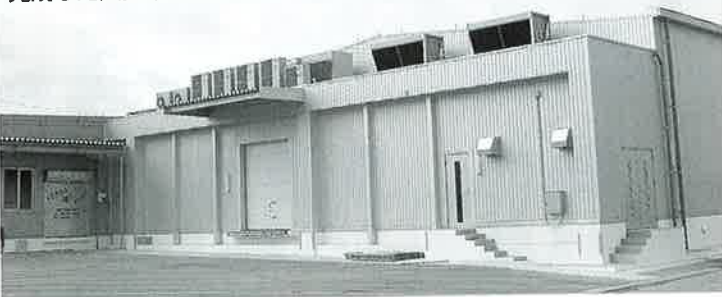
完成した大型冷蔵庫全景
