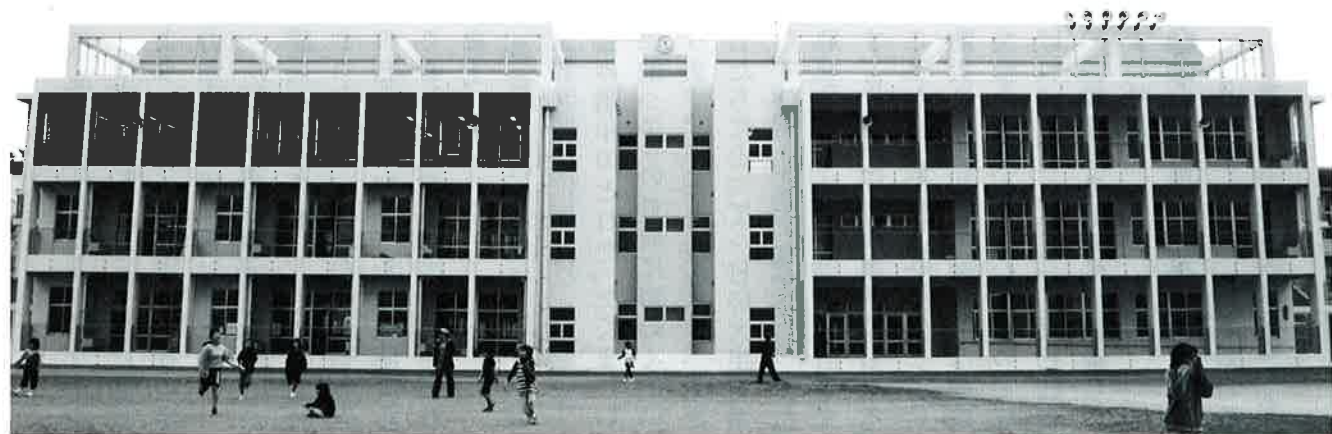
▲平成20年2月に完成した仲泊小中学校新校舎
