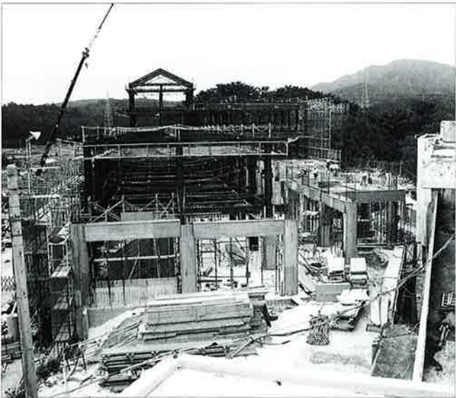
▲着々と建設工事が進む新庁舎
