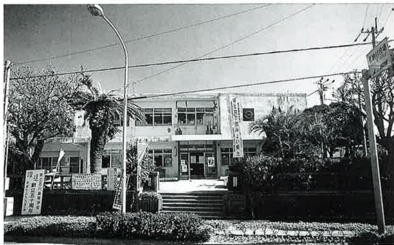
▲現庁舎は、昭和33年から業務が行われており、今年の10月には、新庁舎建設の着手を予定しています。
