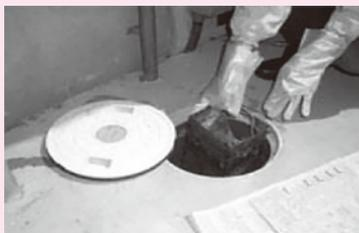
※分離マスは、通常、台所裏手に設置しています。台所裏に設置されている分離マスの中カゴを取り出し、ゴミを取り除いてください。
