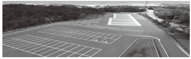
・公営墓地整備事業(南恩納区)
