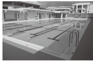
・恩納小学校プール改築工事
