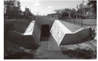
・熱田川改修工事(安富祖区)
