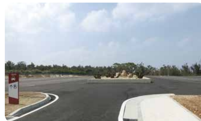
万座毛周辺活性化施設駐車場
