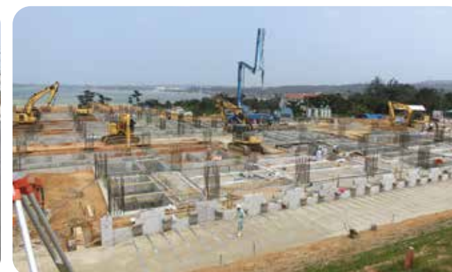
統合中学校整備工事(赤間)
