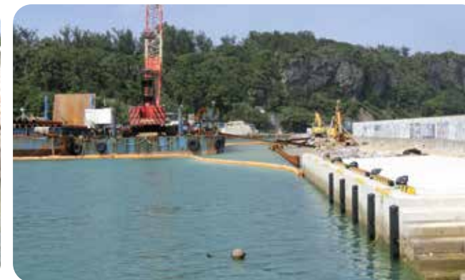
恩納漁港整備工事
