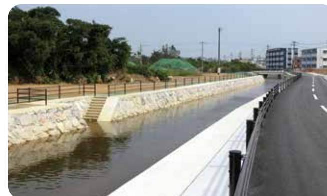
勢高排水路整備工事(南恩納)
