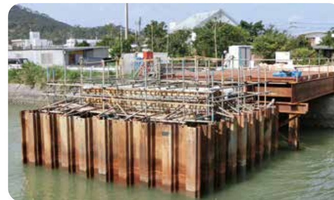
名嘉真川橋梁新設工事
