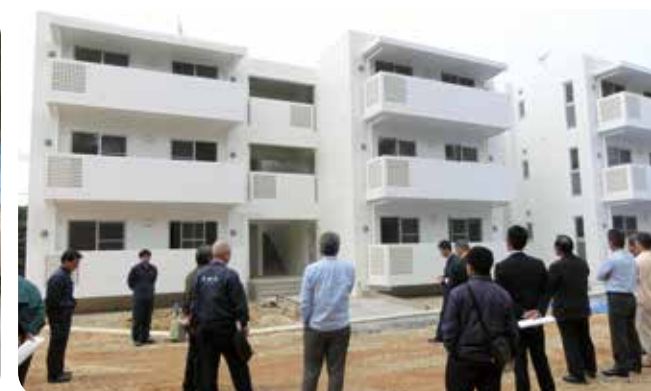
宇加地団地新築工事
