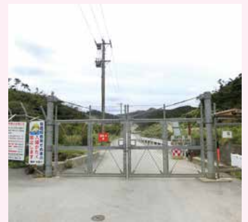
安富祖ダム工事現場の入り口
