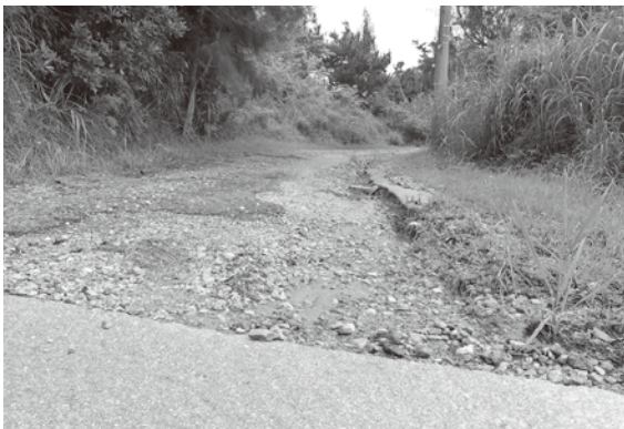
避難路にも指定されている「村道喜瀬武原11号線」の状況
