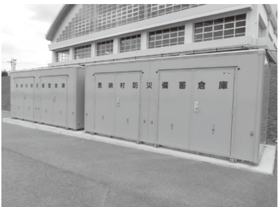
赤間運動場駐車場に設置した備蓄倉庫
