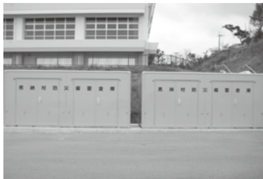
赤間運動公園にある防災倉庫
