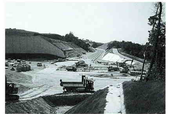
谷茶区内の施工状況
