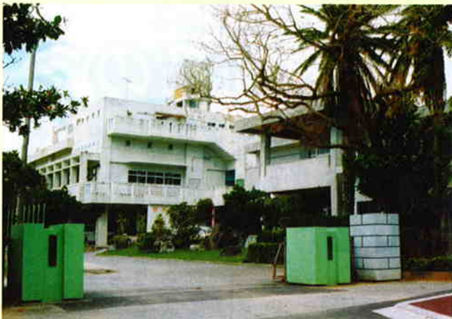
安富祖小中学校(昭和54年建築) 平成21年度改築開始予定
