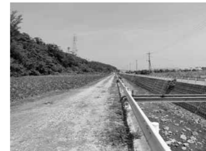
安富祖農道整備工事
