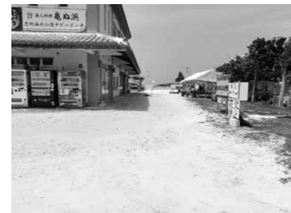
海浜公園構内道路整備事業
