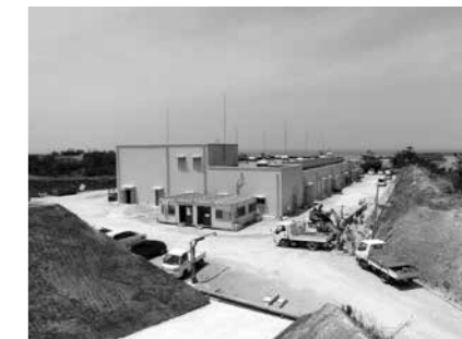
農業集落排水工事（恩納第1）
