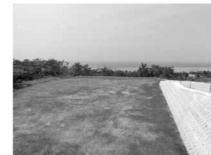
真栄田配水池築造工事
