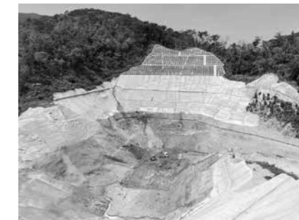
安富祖ダム本体工事
