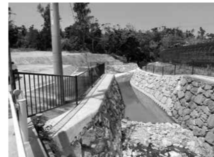
イヌイ川改修工事
