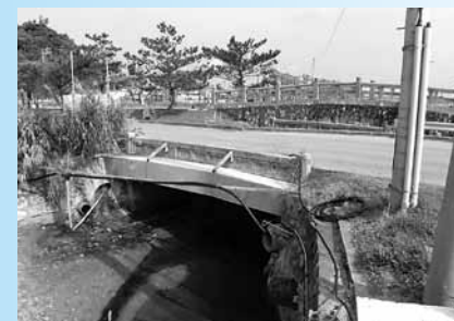
仲泊内海・深川橋掛替
