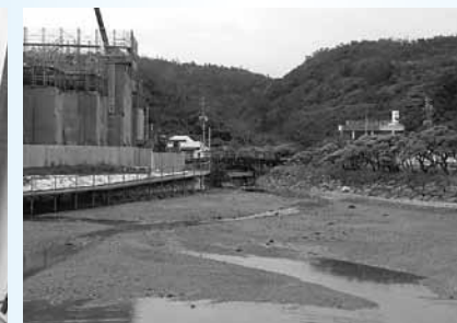
仲泊内海・人道橋整備
