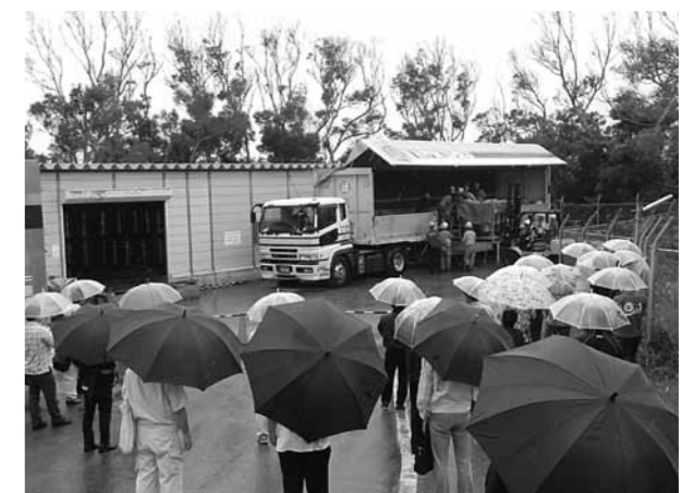
作業状況の確認
