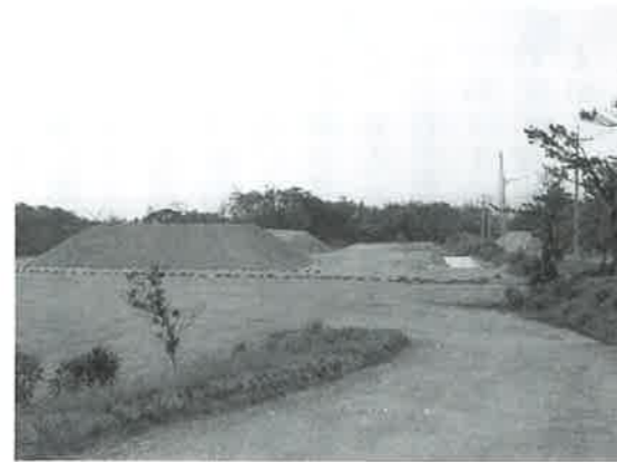
火葬葬祭場周辺の造成地
