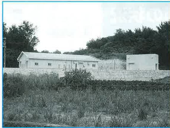
農業集落排水工事（山田地区） 総事業費約21億円の山田地区集落排水事業が年内にも完成し試運転が始まりそうです。処理施設は、太陽光発電など、最先端の技術が導入されています。
