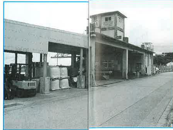
漁村環境改善施設整備事業 現在ある荷捌き場を新しく立て替える工事です。床面積は、1階493.55㎡ 2階135.06㎡となります。
