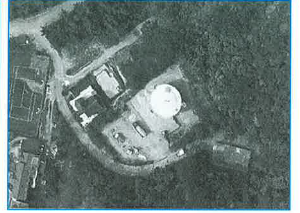
希望ヶ丘地区上水道施設工事 古い水道管の新しい管への取替え工事です。送水管200mmが310m 配水管150mmが314m
