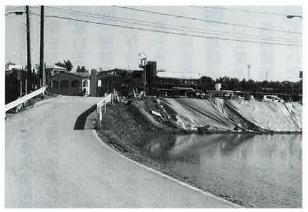
安富祖川沿いの国道からの侵入路
