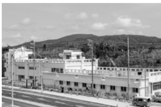
金武地区消防恩納分遣所
