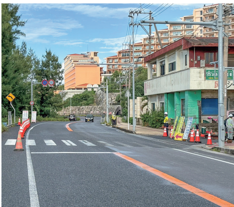
▲カフーリゾート前横断歩道
