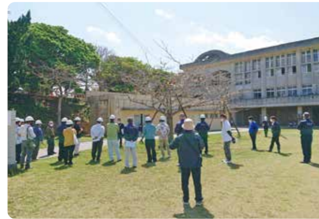
山田小学校プール整備工事
