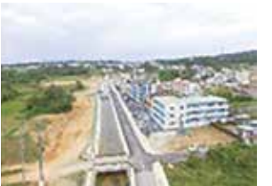
勢高排水路・2号線整備
