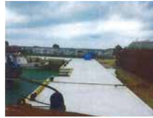
▲恩納漁港(-2.5m物揚場)
