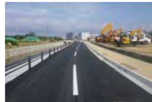
▲勢高1号:250m完成(南恩納区)
