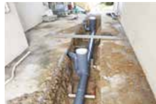
▲下水道宅内配管工事
