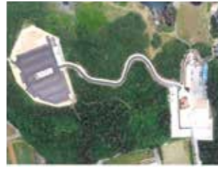
▲万座毛(第二駐車場完成・左側)
