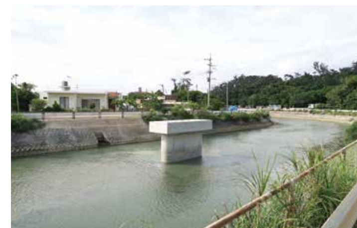
名嘉真川橋りょう整備工事
