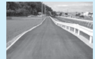
・安富祖農道整備工事
