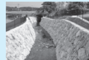
・イヌイ川改修工事
