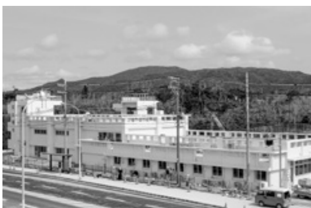
金武地区消防恩納分遣所
