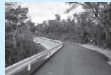
・村道前山線整備工事
