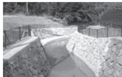
イヌイ川改修工事 ・喜瀬武原のイヌイ川(上流部L=55m)親水性護岸として整備しました。
