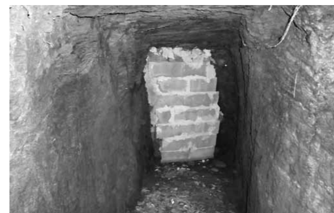
大道原の壕内(千枚岩を掘り込んで造られていました。)
