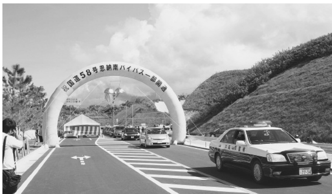
▲開通した恩納南バイパス
