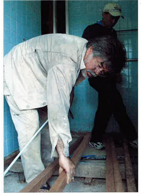
▶ 趣味の日曜大工を生かして東さん宅の洗面所床板の張替えをする上間守一さん
