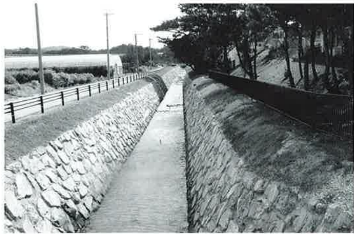
◀平成16年12月に完成した恩納保育所裏の新川改修工事
