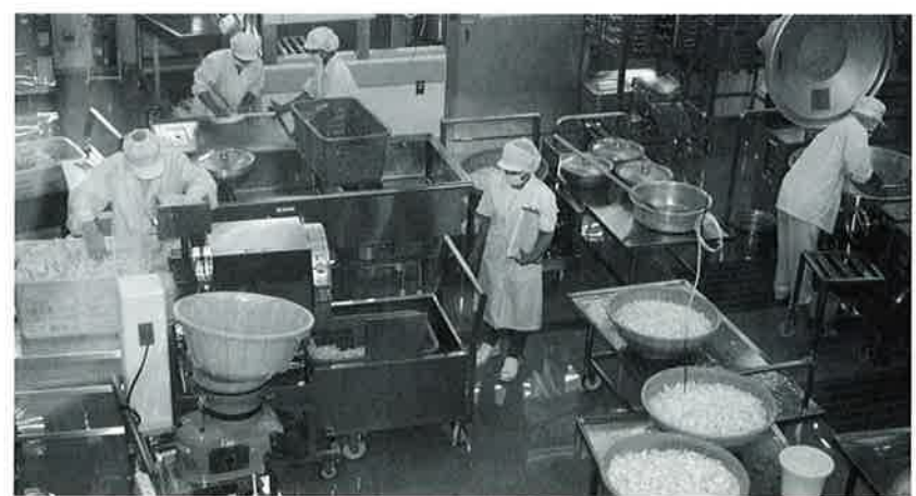
◀沖縄初のオール電化ドライシステム厨房の給食センター
