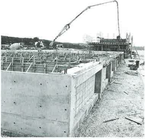
▼水産業活性化構造改善事業を導入して真栄田漁港内に建設中の海ぶどう養殖施設。
