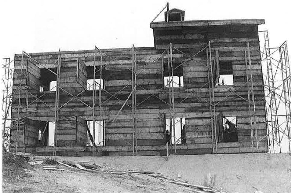
一九八八年十月三日 演習場内に不可決な建造物の建設を発見！ 一九八八年十二月十二日 悪魔の部隊、グリーンベレーの「都市型戦闘訓練施設 であることが判明
